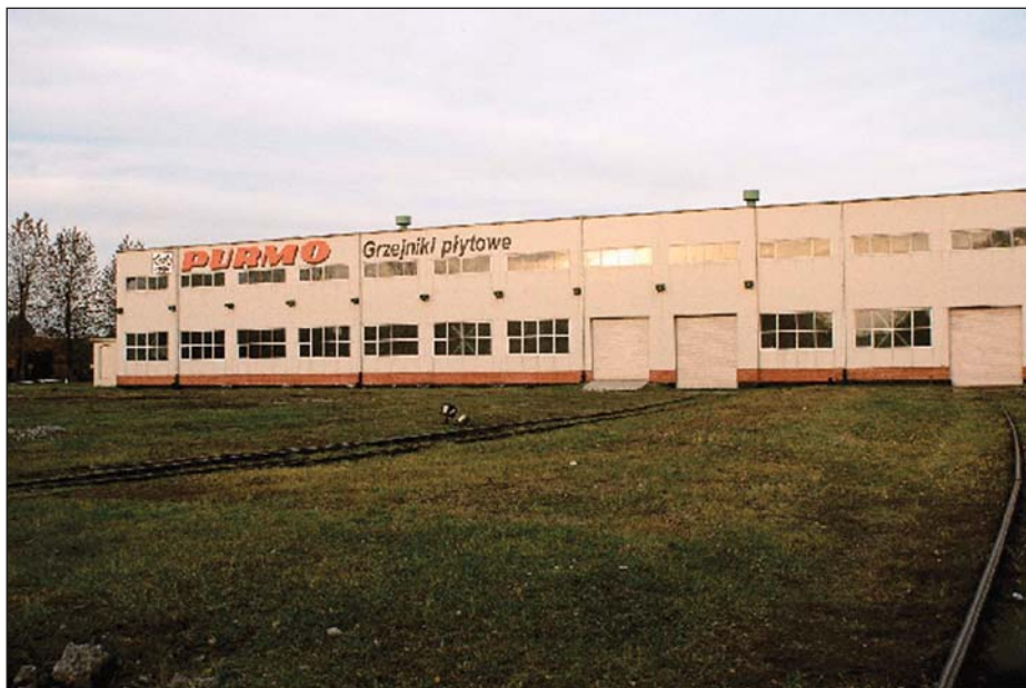
Zdjęcie 4. Nowoczesne hale fabryczne – Rettig Heating
